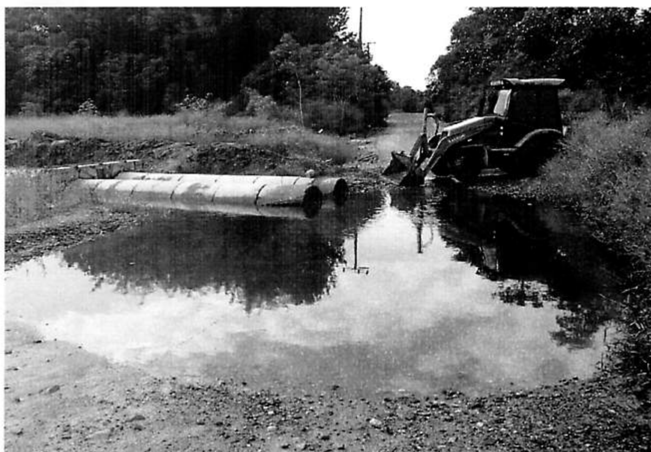
Conserto estrada Vila da Glória (emergencial)
