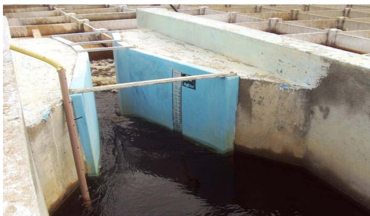
Figura 37: Calha Parshall
