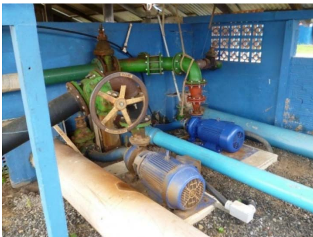
Figura 56: Conjuntos Motobombas Existentes na ETA Principal
