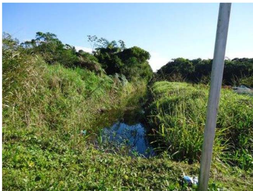
Figura 155: Assoreamento da Macro drenagem com Valas Superficiais
