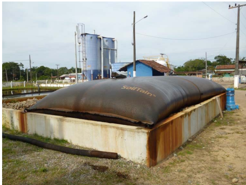
Figura 53: Sistema de Bag para Desidratação do Lodo das Lagoas de Decantação da ETA Principal
