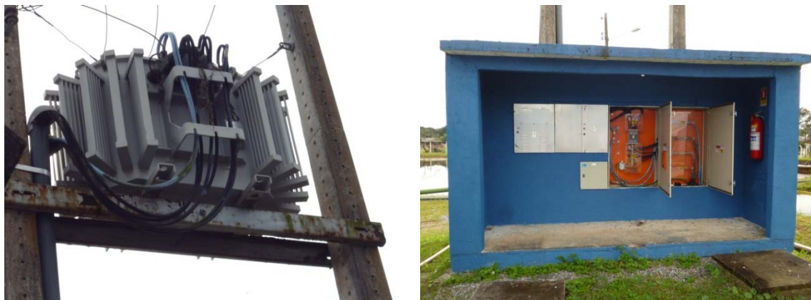
Figura 60: Vista Geral do Novo Transformador e Painéis de Entrada de Energia Elétrica da ETA Principal
