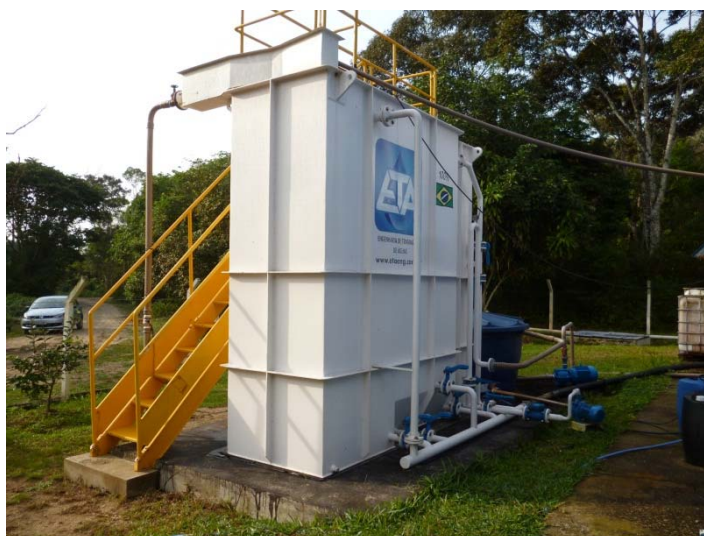
Figura 73: ETA Compacta – 5m 3 /hora
