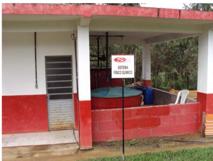
Figura 142: Tratamento Físico-Químico do Chorume
