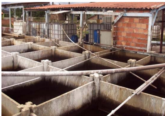
Figura 40: Fluxo da Água no Floculador
