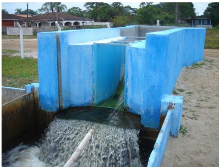
Figura 38: Calha Parshall
