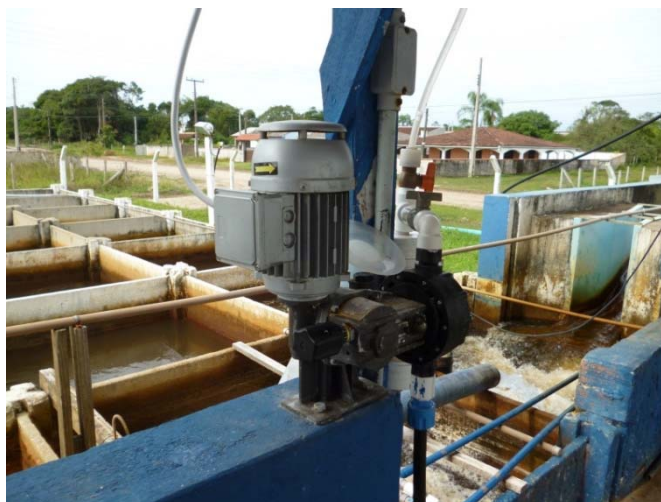
Figura 62: Bombas Dosadoras da ETA Principal
