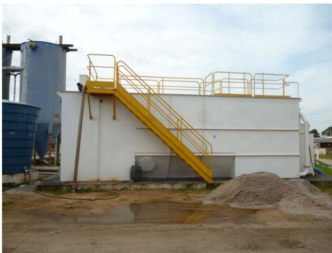
Figura 58: ETA Compacta – 50 m 3 /hora
