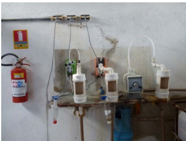
Figura 57: Instrumentos Dosadores da ETA Principal
