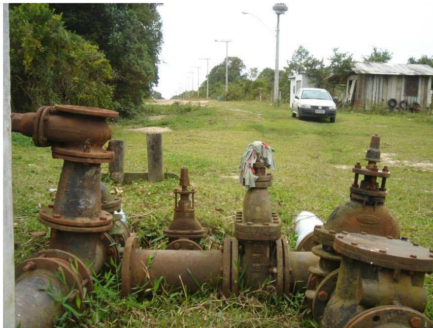
Figura 34: Adutoras da ETA Principal – 2 Linhas de DN=200 mm em Ferro Fundido
