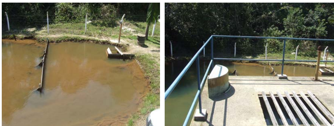
Figura 67: Lagoa de Decantação – ETA Secundária
