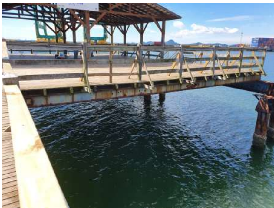
Figura 7 - Estrutura de sustentação com furos.
